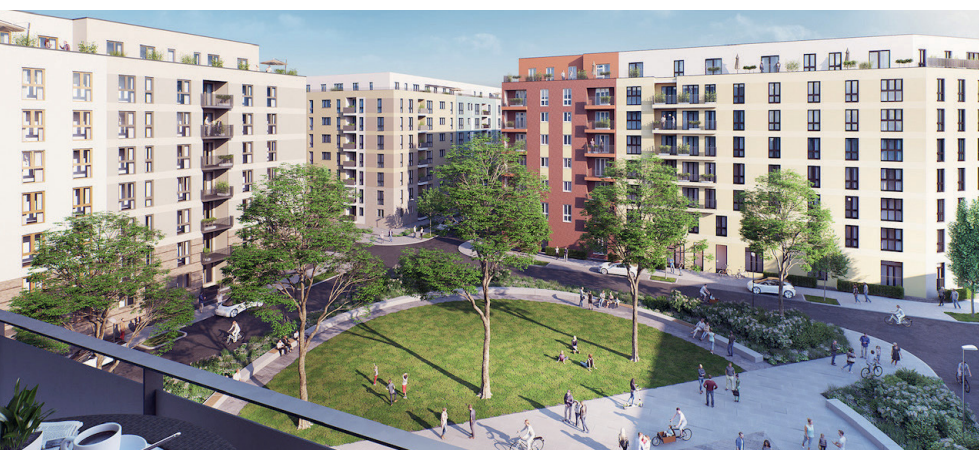
Bei der Beheizung der einzelnen Mietwohnungen setzen die Planer auf einen Mix aus Fernwärme und der Abwärme eines benachbarten Rechenzentrums.
